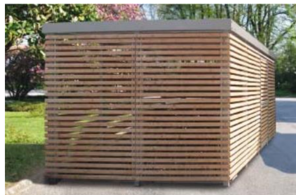
Lesena ograda s streho
