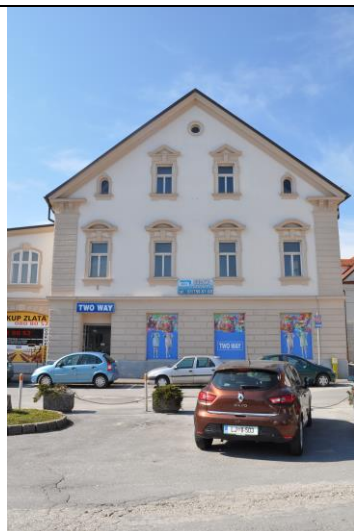
neprimerno polepljene odprtine v pritličju
