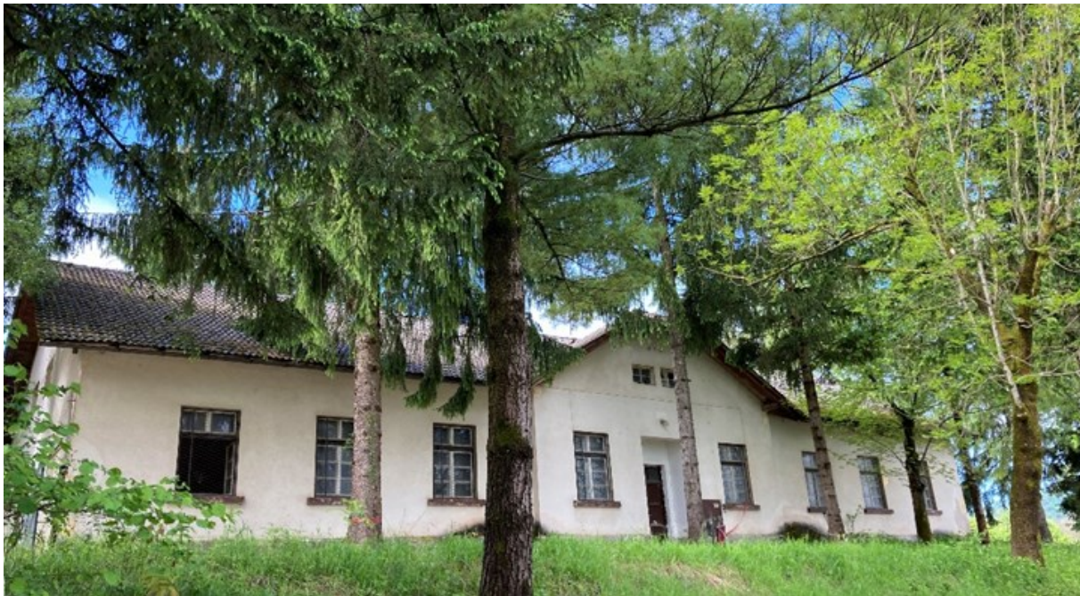
Slika 6 Pogled na severno fasado dotrajanega objekta, z dne 18. 5. 2021
