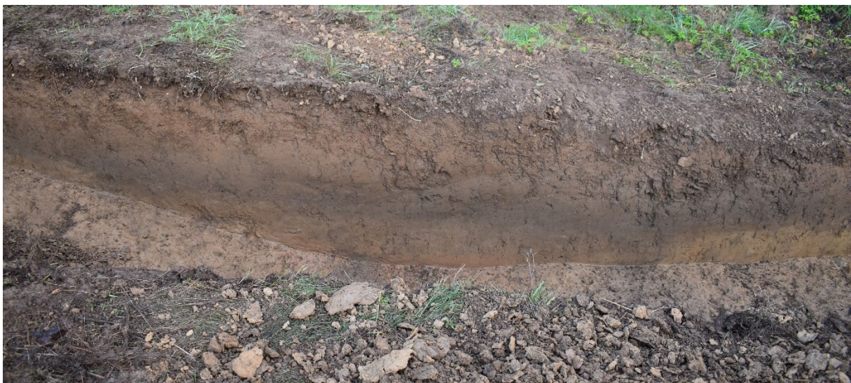
Slika 4: glej naslednjo stan.
