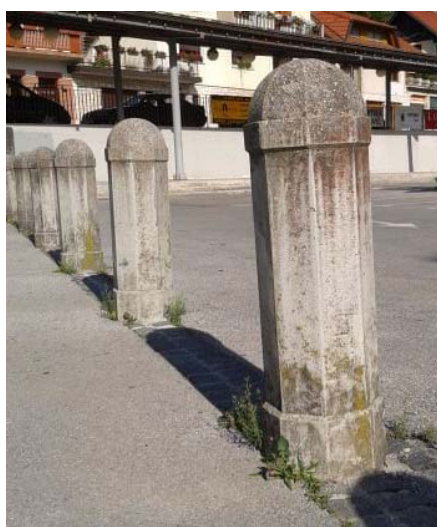
Betonski steber - obstoječ
