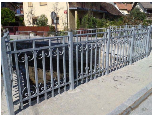
Kovana ograja na mostu čez Belo
