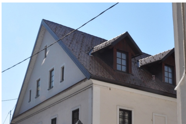
primerna izvedba frčade (oblika in material)
