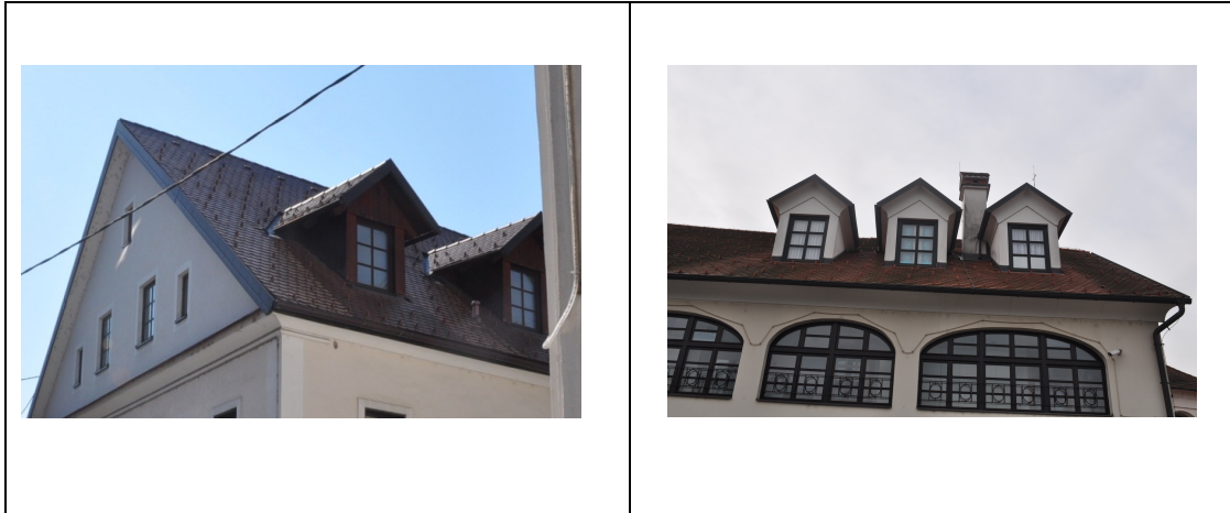
primerna izvedba frčade (oblika in material)
