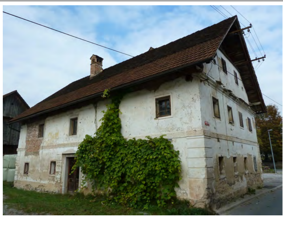
Pogled na objekt iz JV strani (objekt 1)
