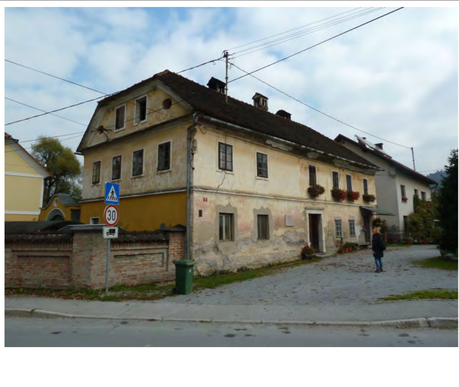
Pogled na objekt iz JZ strani (objekt 1)
