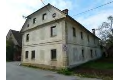
Členitev S in V fasade. Ohranjena enakomerna razporeditev oken z okvirji v ometu ter rustika na vogalih v pritličju.
