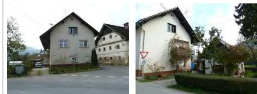
Pogled na stanovanjski objekt iz SV smeri (objekt 1)
