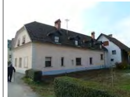
Pogled na S fasado stanovanjskega objekta. Razvidna sprememba okenskih odprtin. V ozadju gospodarski objekt.
