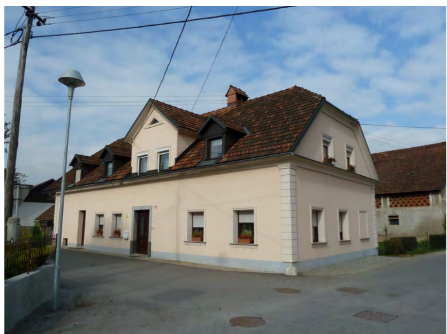
Pogled na objekt iz JV strani (objekt 1)
