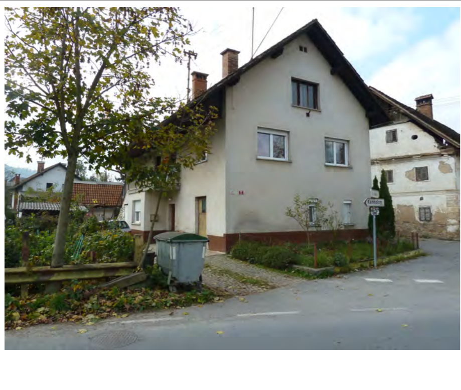
Pogled na stanovanjski objekt iz SV smeri (objekt 1)
