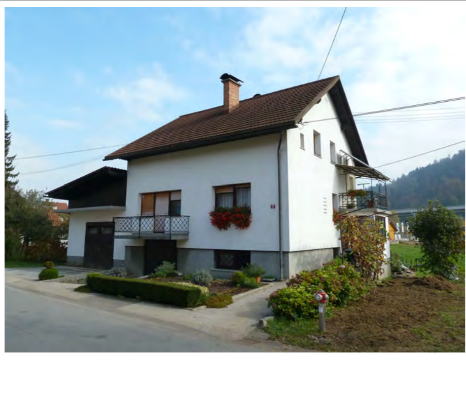
Pogled na stanovanjski objekt iz JZ smeri
