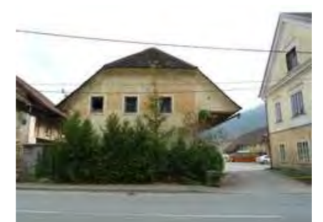
Ulična fasada gospodarskega objekta, z uvozom na parcelo. V ozadju so delno vidni ostali gospodarski objekti na parceli.
