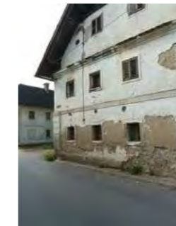
Členitve na V fasadi. Razvidno originalno gradivo (kamen).
