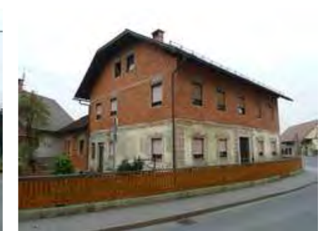
Pogled na J in V fasado stanovanjskega objekta.
