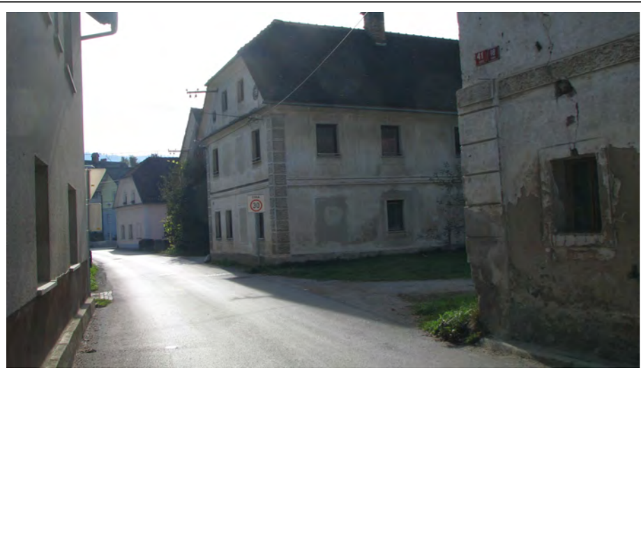
Pogled na ulico s severne strani
