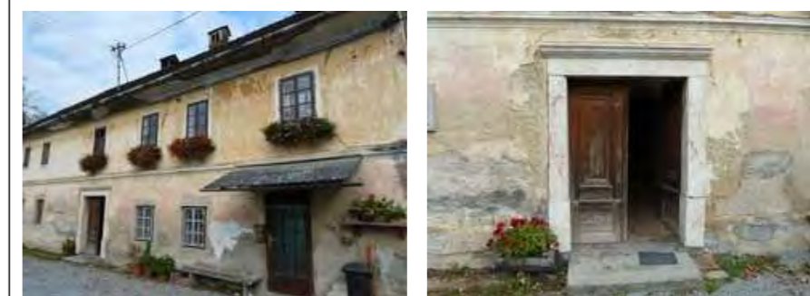
Pogled na J fasado. V pritličju kamnit portal in sekundarni vhod. Vidne poškodbe ometa.
