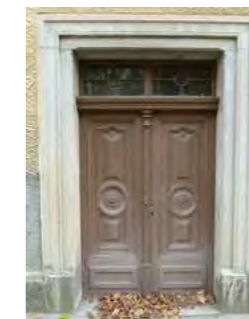
Detajl kamnitega profiliranega portala na pročelju.
