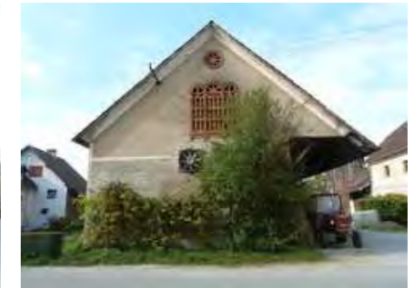
Detajl opečnih zračnikov, ki spominjajo na triforo.
