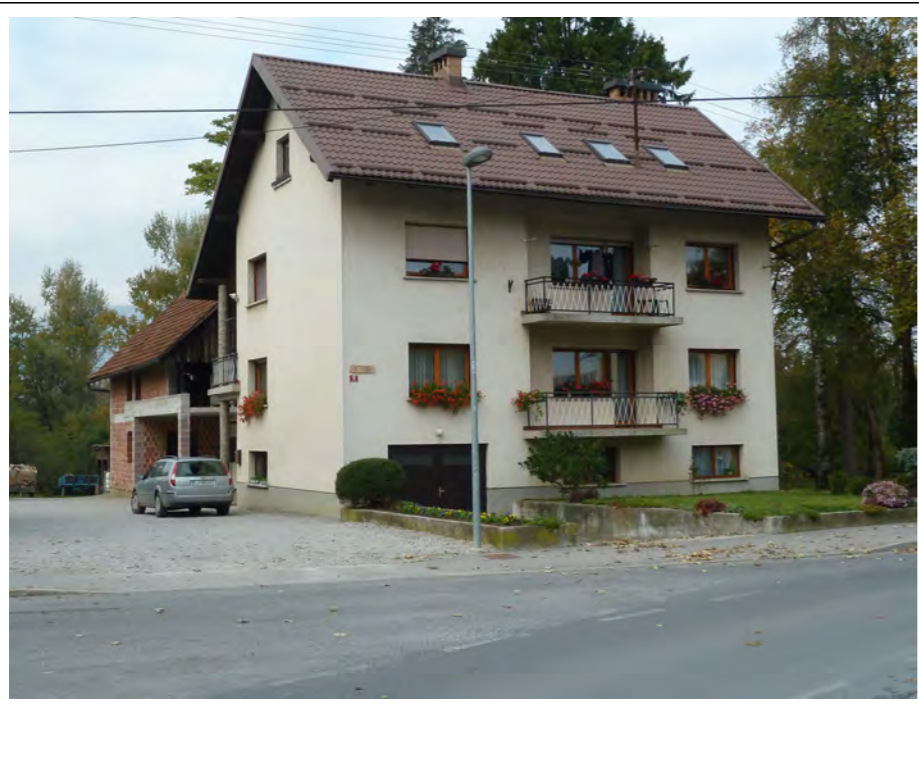
Pogled na objekte iz JV strani. Stanovanjski objekt (1), v ozadju nedokončana prizidava (objekt 2).
