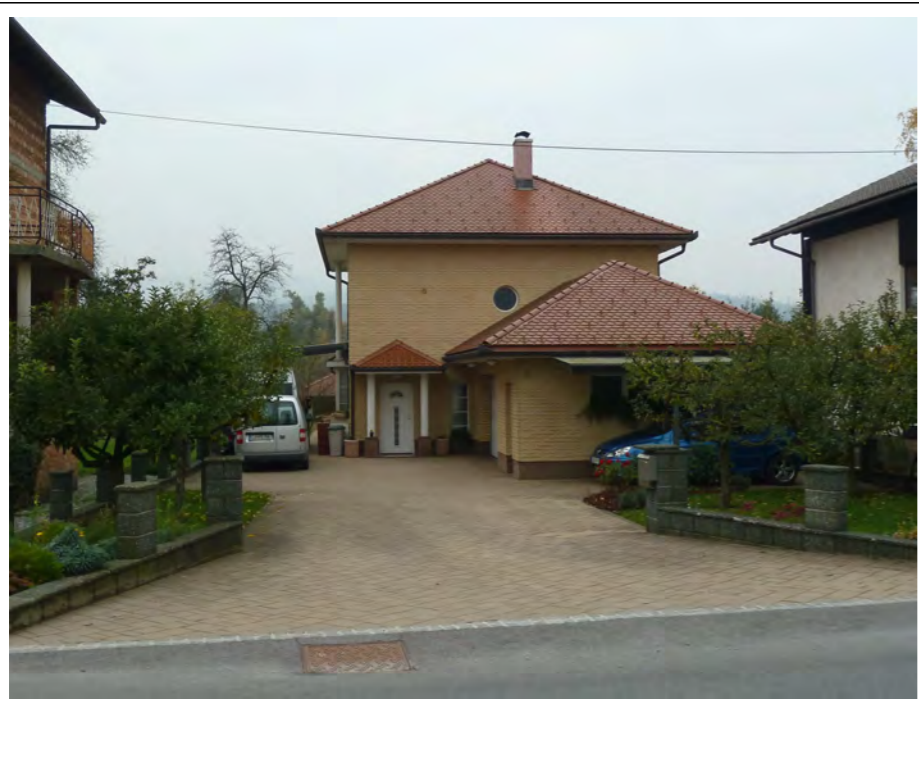
Pogled na V fasado objekta
