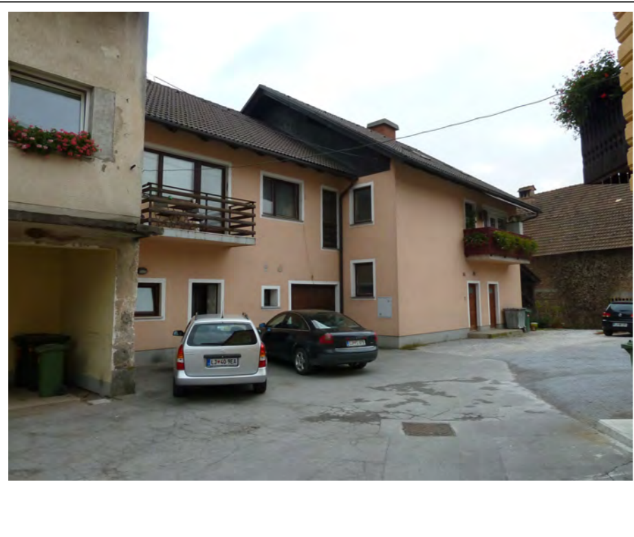
Pogled na stanovanjski objekt iz SZ smeri (objekt 1)
