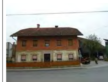
Pogled na V fasado stanovanjskega objekta. Pritličje originalno, prvo nadstropje in mansarda naknadno zgrajena.
