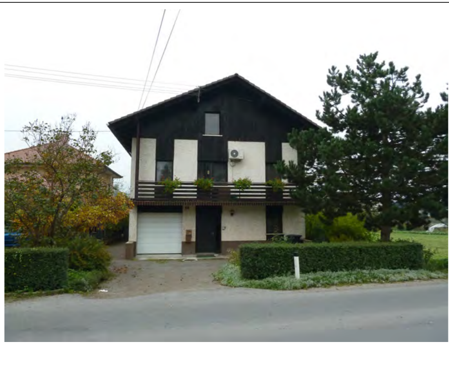
Pogled na V fasado objekta
