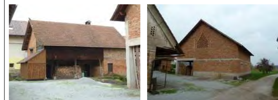
Kmetijski objekt na Z delu parcele. Pogled na V fasado.
