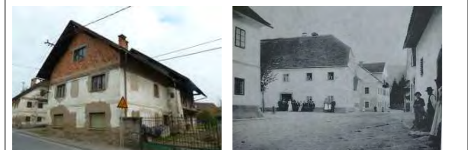
Pogled na S in Z fasado. Ograja, pozicije zazidanih oken in porušen del objekta na stiku z novjšim prizidkom.
