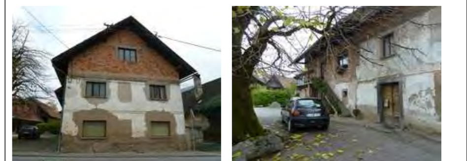
Razvidne so pozicije zazidanih oken v pritličju in prvem nadstropju Z fasade
