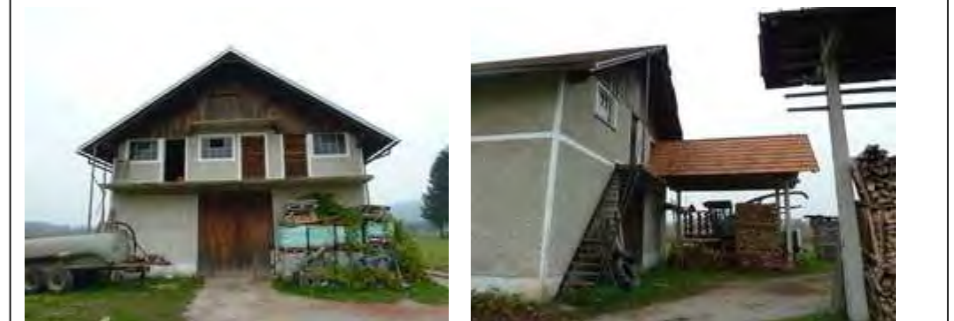
Zahodna fasada objekt 1
