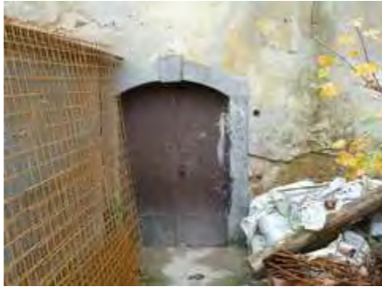
Detajl kamnitega portala na S fasadi, gospodarski objekt.
