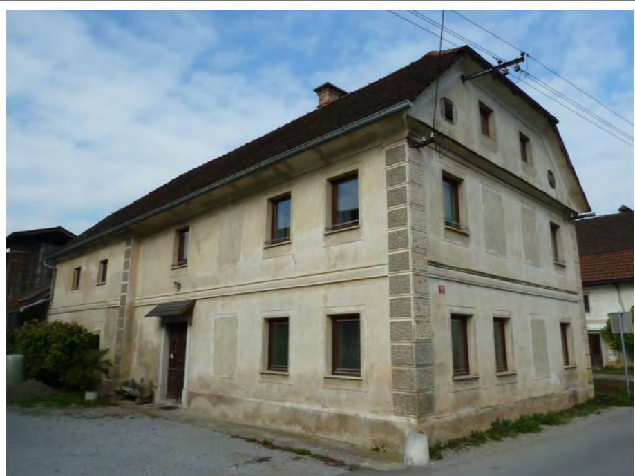
Pogled na objekt iz JV strani (objekt 1)
