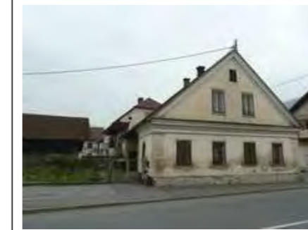
Pogled na Z fasado stanovanjske stavbe
