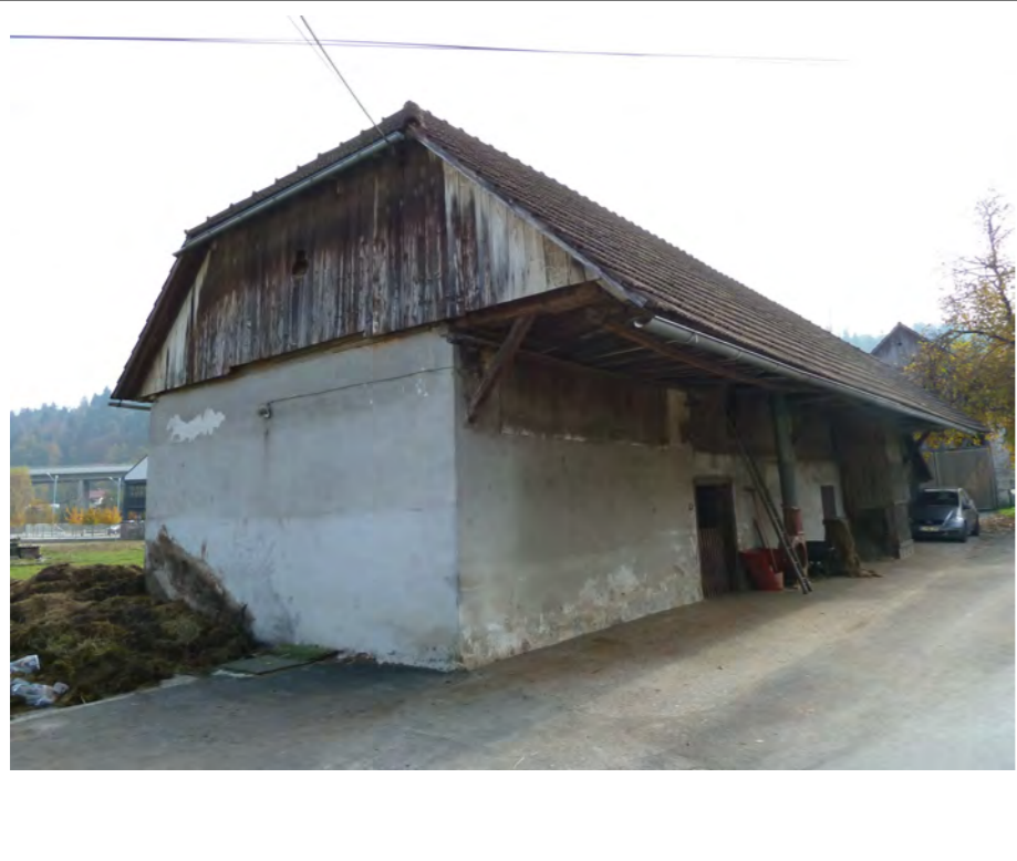
Pogled na gospodarski objekt iz SZ strani (objekt 1). V ozadju kozolec (objekt 2).
