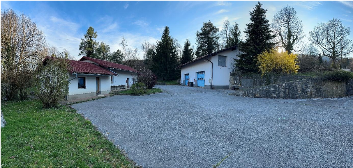
Slika 23: Prikaz obstoječih objektov na območju obdelave - objekta 3 in 4 (levo) ter objekt 6 (desno) (Vir fotografije: J. Medved, Domplan, d.d., marec 2026)
