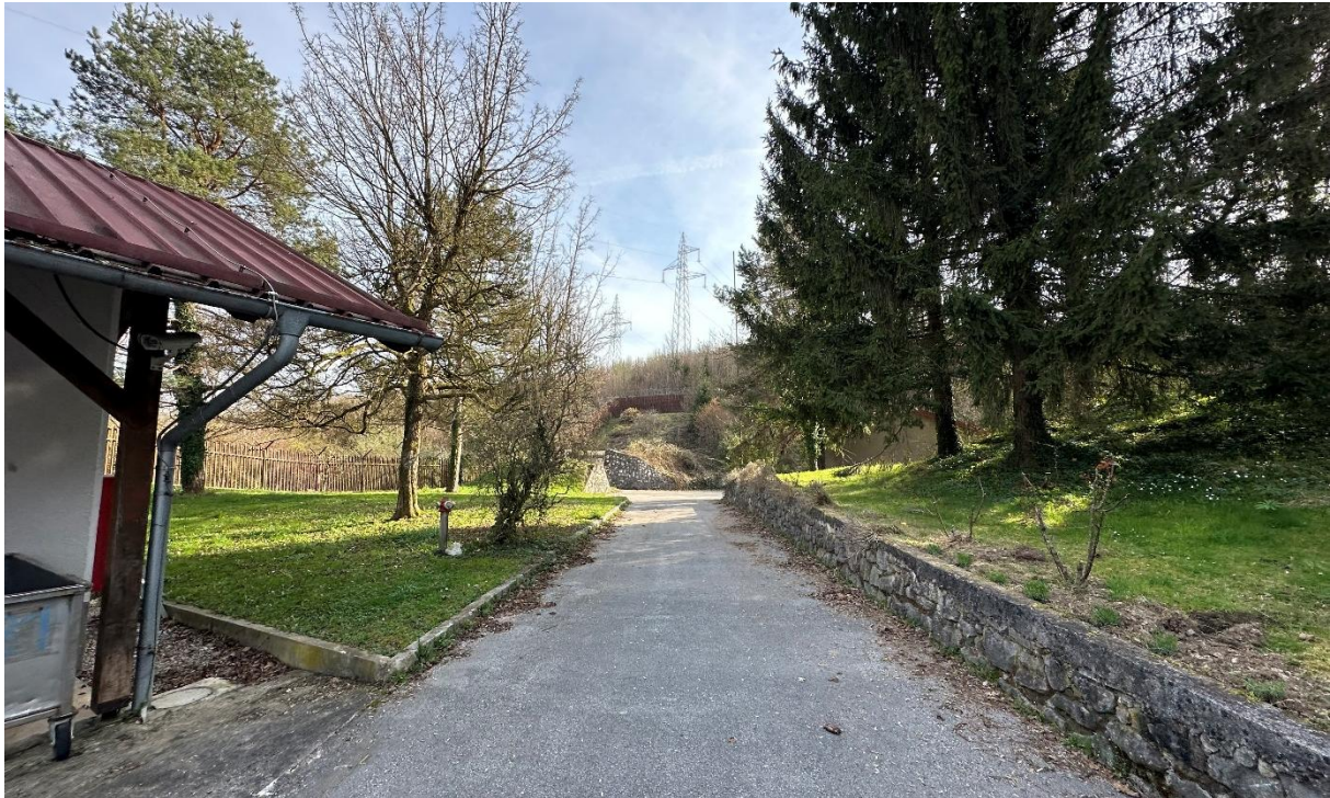
Slika 25: Prikaz obstoječih objektov na območju obdelave – del objekta 5 (levo), objekt 8 (sredina) in objekt 1 (desno) (Vir fotografije: J. Medved, Domplan, d.d., marec 2026)
