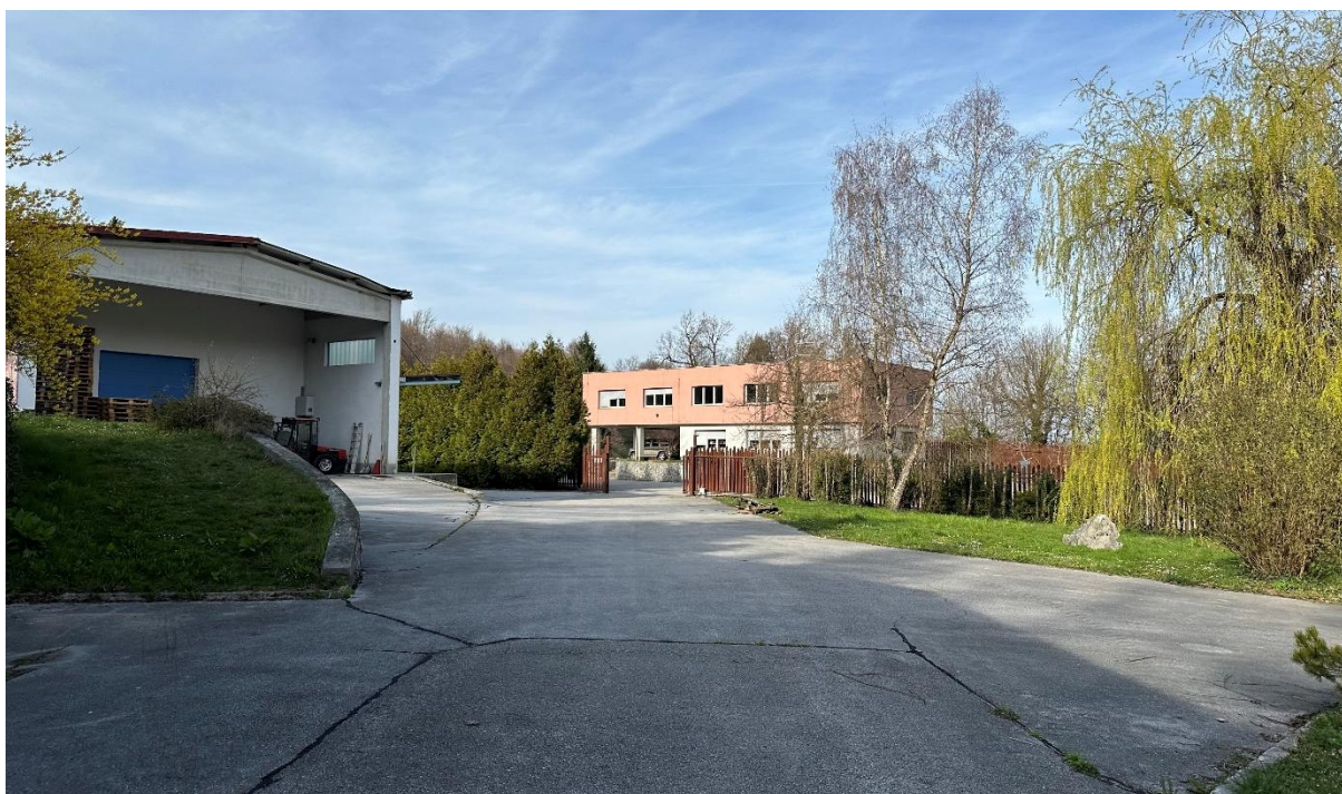
Slika 22: Prikaz obstoječih objektov na območju obdelave - objekt 2 (levo) in objekt 9 (desno) (Vir fotografije: J. Medved, Domplan, d.d., marec 2026)
